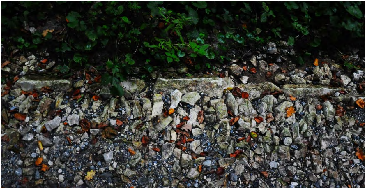
Abbildung 34: Alte Wegebefestigung durch Randsteine und gesetzte Packlage aus örtlichen Kalksteinen im Brichloh (Foto Oktober 2023)
